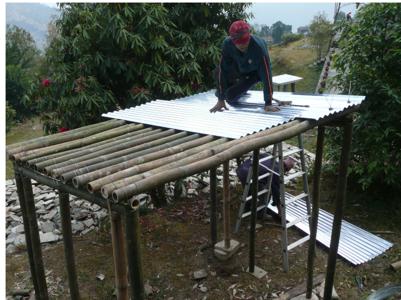
Eksperimentell takkonstruksjon med bølgeblikk, bambus og torv.
