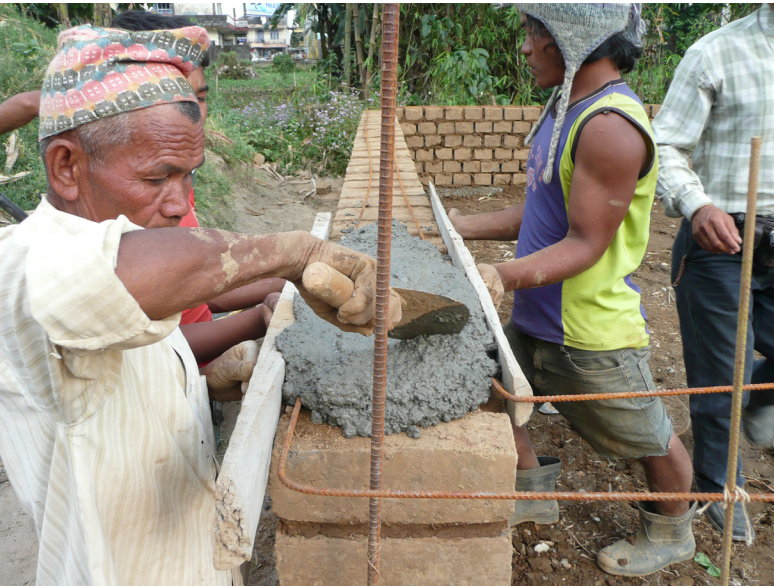
Bygging med armert murverk.
