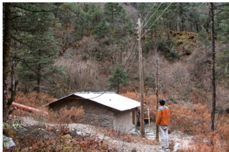
Mikrokraftverket som gi elektrisitet til husene der de bor høst, vinter og vår.
