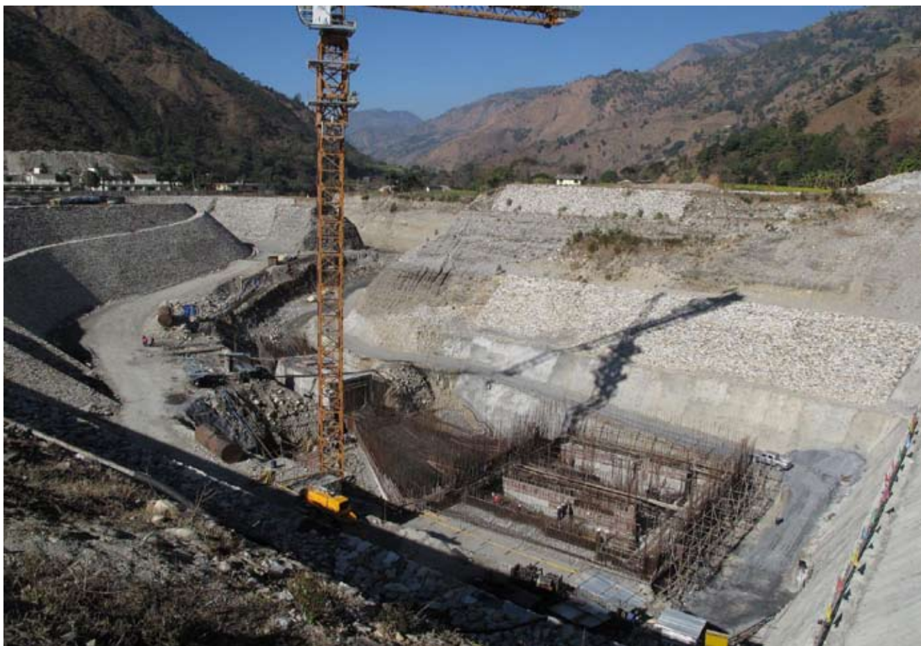
Byggingen av Chameliya kraftstasjon i Butwal.
