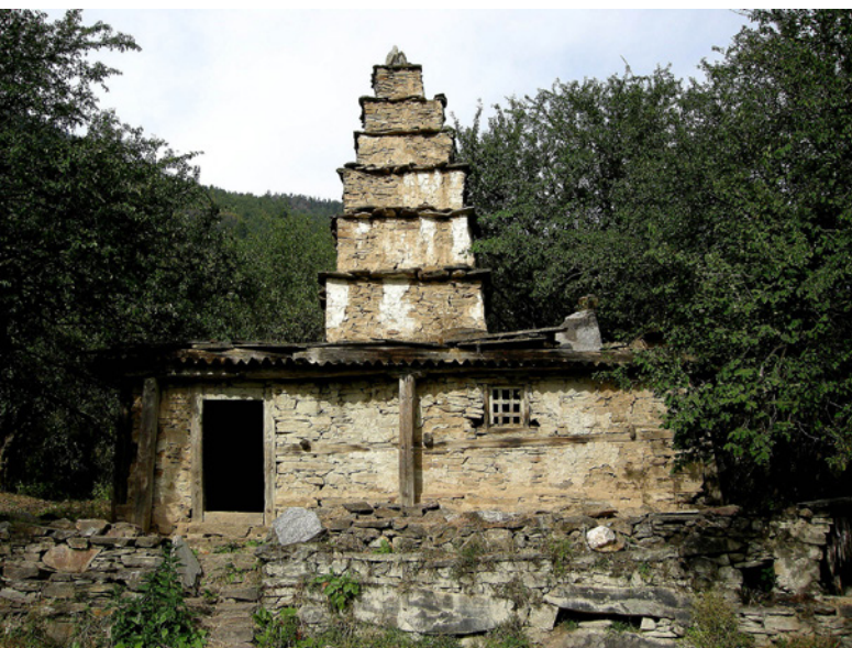
Den gamle manduen med kollapset tak.
